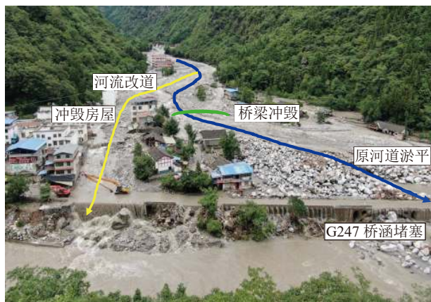
图1 2022年四川平武“7·12”山洪灾害
